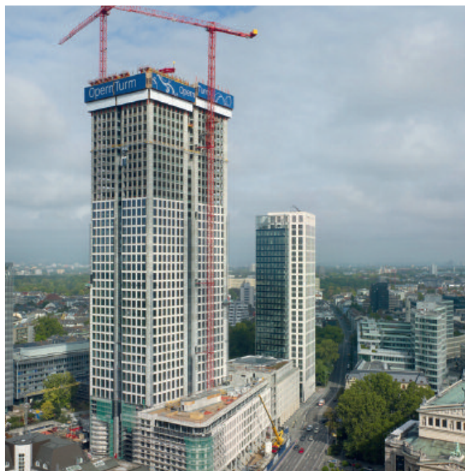
Der Frankfurter OpernTurm in der Bauphase.
