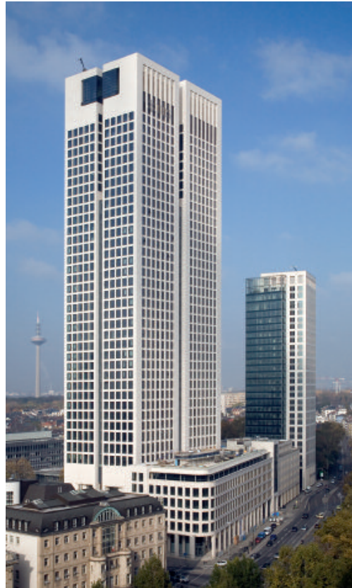
Fassaden mit Glas- und Natursteinkonstruktionen
